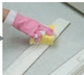
下枠前カバーの汚れを取る。
