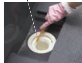
● 排水トラップ本体
