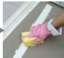
下枠前カバーの汚れを取る。
