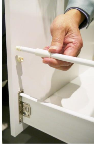
サイドレールを元の位置に戻しフロントカバーを取付けます
