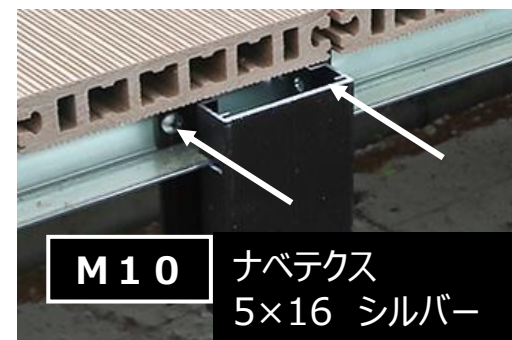
デッキ木口側（根太材木端側）
