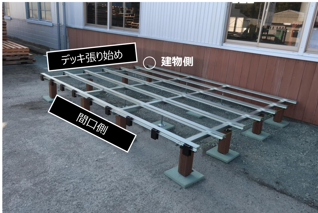
建物側（根太材木口側）
