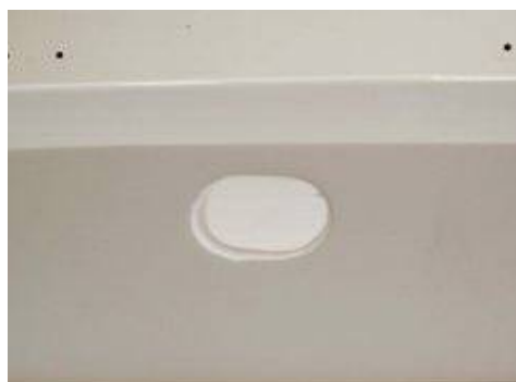
【アンカーボルト穴部】
